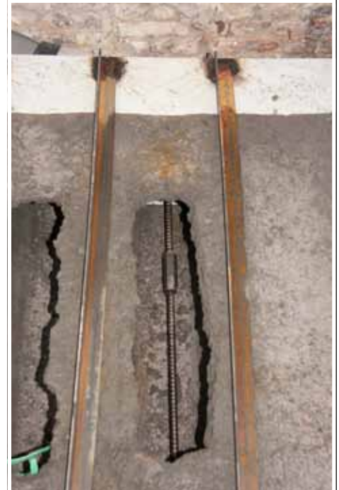
Ingenieus montagesysteem bij randliggers/welfels _Système de montage ingénieux poutres de rive/voûtes
