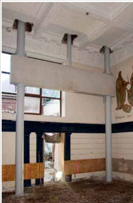
Staal-betonconstructie in het Vrederecht. Construction mixte dans la Justice de Paix
