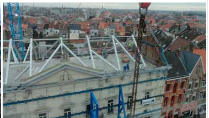
Dakstructuur in staal_Construction métallique de la toiture
